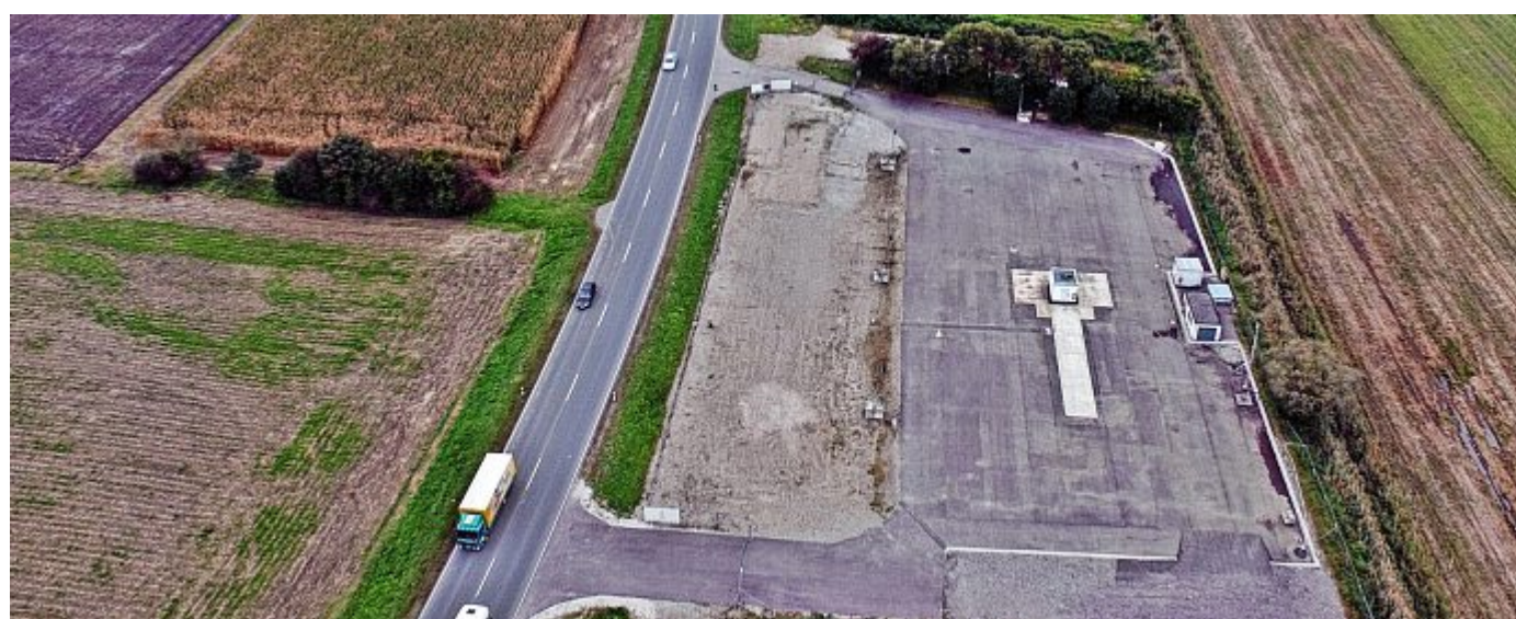
Nach dem ersten Fördertest sind die Gerätschaften noch abgebaut. In der kommenden Woche wird begonnen, erneut eine 33,50 Meter hohe Arbeitswinde zu errichten.
