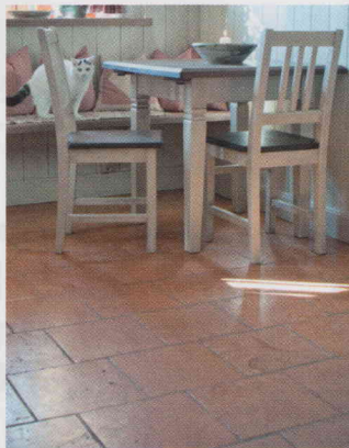
Attenberger Bodenziegel aus Seeton im Utzbof Gollenshausen
